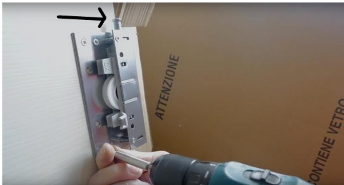
Visser les deux mécanismes inférieurs sur la partie inférieure de la porte (côté intérieur).
