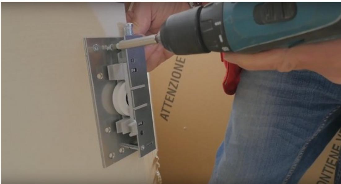
**IMPORTANT:** Cette vis doit être serrée pour régler la hauteur des portes uniquement si le sol de la pièce n'est pas parfaitement droit.
